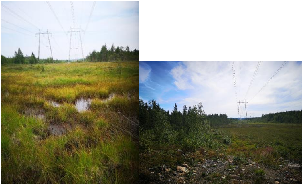
Kuva 9-4. Vasemmalla Kotasuon ruopparimpeä olemassa olevien voimajohtojen ja oikealla yleiskuvaa olemassa olevasta johtoaukeasta Rynnäsentien alueelta kohti etelää (hankealueen suuntaan) kuvattuna. Suunniteltu voimajohto (SVE2) sijoittuu kuvassa näkyvistä voimajohdoista katsoen vasemmalle puolelle.
