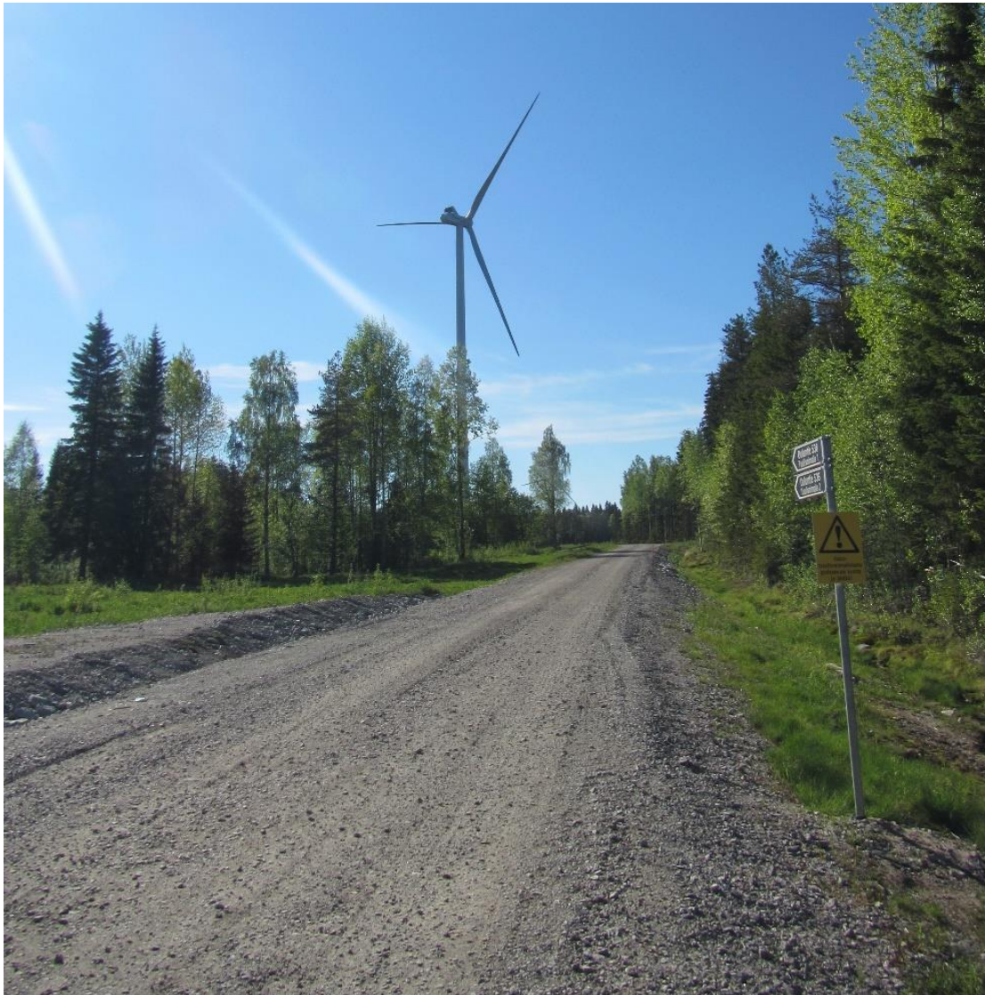
Kuva 2-6. Esimerkki tuulipuiston rakennus- ja huoltotiestä. © AFRY Finland Oy.
